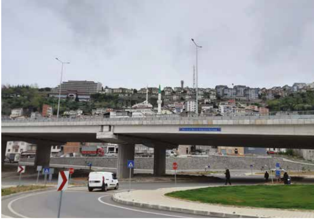
Kanuni Bulvarı güzergâhından
