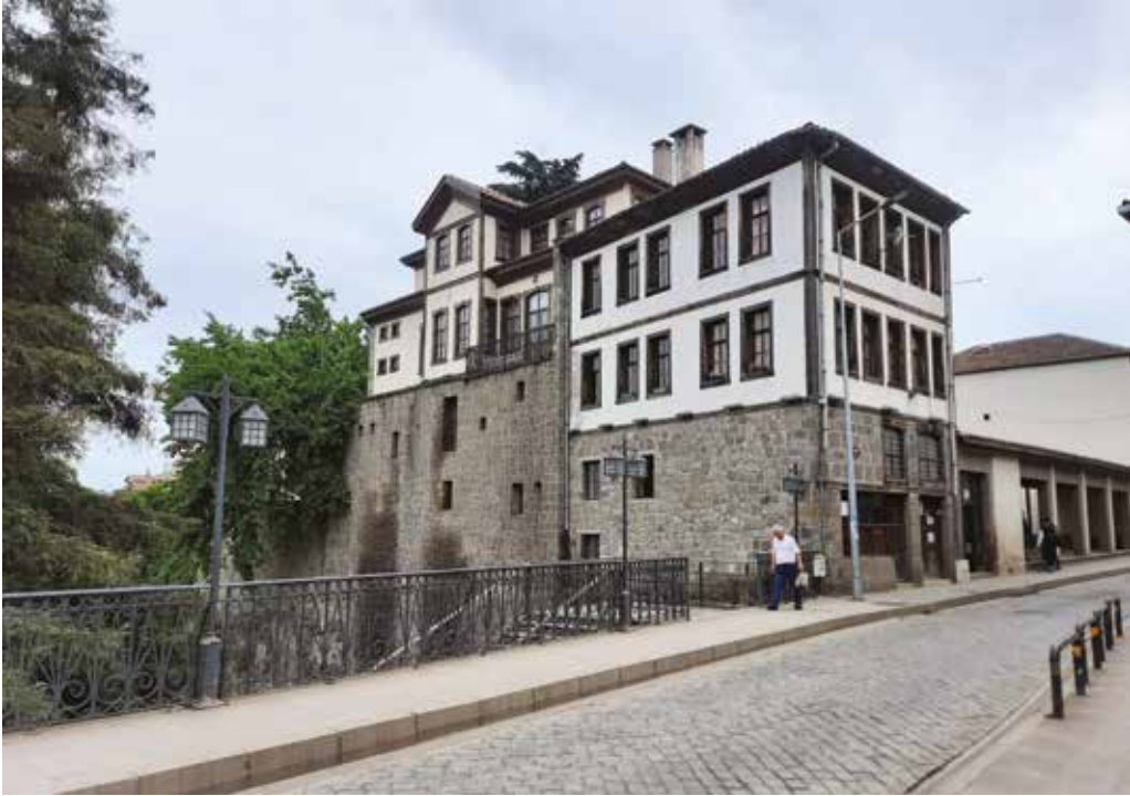
Zağnos Köprüsü ve Ortahisara geçi silüeti belirleyen binalardan
