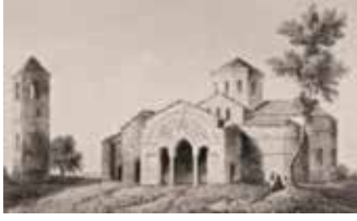
Trabzon Ayasofya Kilisesi
