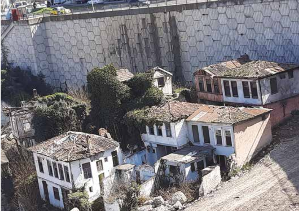
Çömlekçi Dönüşüm Projesi ve Tanjant Yolu uygulamalarının buluşması, 2025 Yılı
