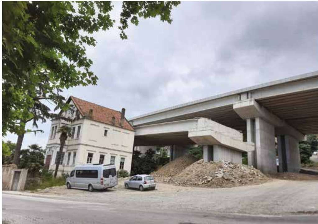
Kanuni Bulvarı güzergâhından
