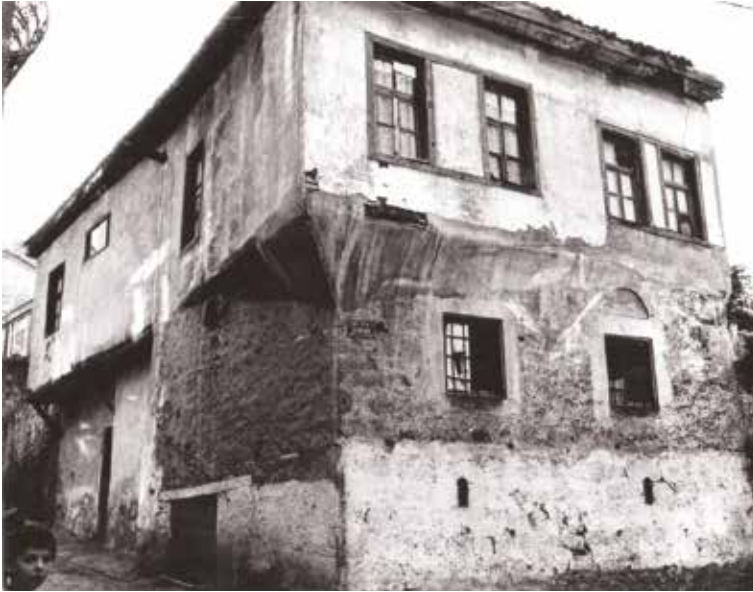
Foto 7. Köşe Konutu: 1. No'lu Deniz Sokak
