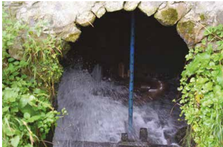
Suyun çarka vurmasını sağlayan sinbon ve değirmen taşı döndüren çark
